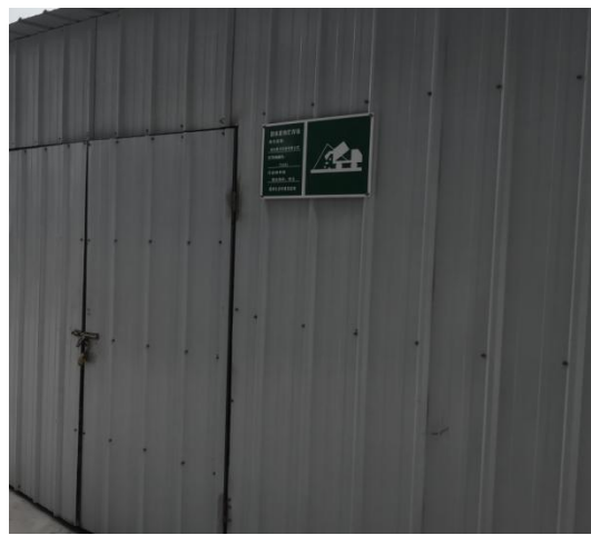
一般固废暂存间
