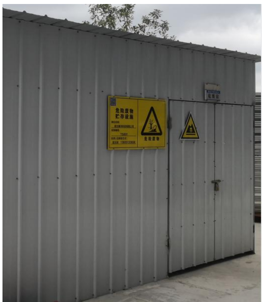
危险废物暂存间
