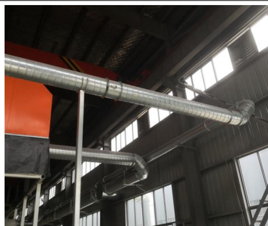
熔化炉烟粉尘废气集气罩
