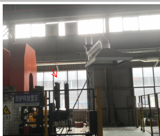
熔化炉烟粉尘废气集气罩
