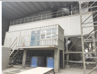
布袋+重力除尘设施
